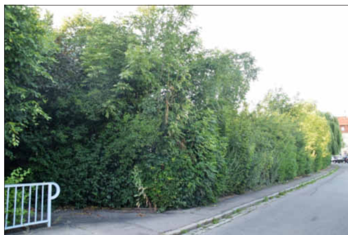
Grün ummantelt ist derzeit nach das alte Gärtnerriegelände an der Sparkassenstraße. Hier soll einmal das Gesundheitszentrum entstehen.
